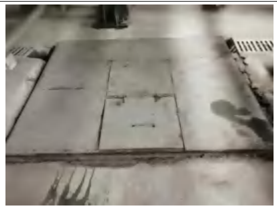
1号车间收集池-2
