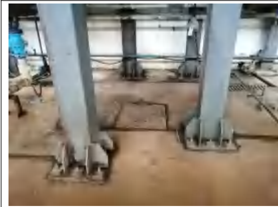
2号车间收集池-1
