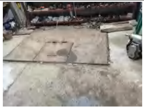
2号车间收集池-2
