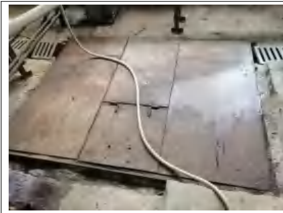
1号车间收集池-1
