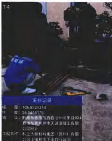
T4 危废暂存间北侧
